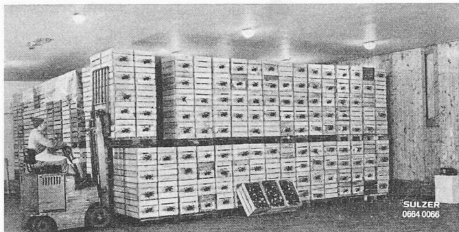
Bild 5. Für Obstlagerung verwendeter Kühlraum im Kellergeschoss mit Mantelkühlung
