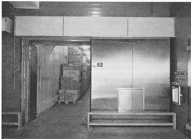
Bild 14b. Handbetätigte geöffnete Schiebetüre für den Gefriertunnel (links) und elektrisch angetriebene geschlossene Schiebetüre für den Tiefkühlraum (rechts)
