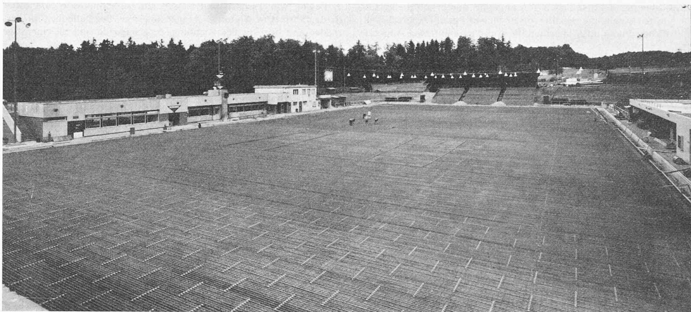
Bild 7. Die Piste von 6000 m 2 beim Verlegen der Röhren (Juni 1963)
