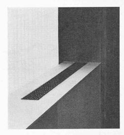
Bild 6 (rechts). Ausblasgitter einer Hochdruck-Klimaanlage an der Fensterbank und vertikale Lamellen-
