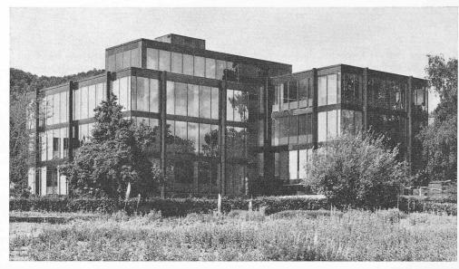
Bild 1. Glasfassade des Verwaltungsgebäudes der Ventilator AG, Stäfa mit Stop-Ray-Festverglasung
