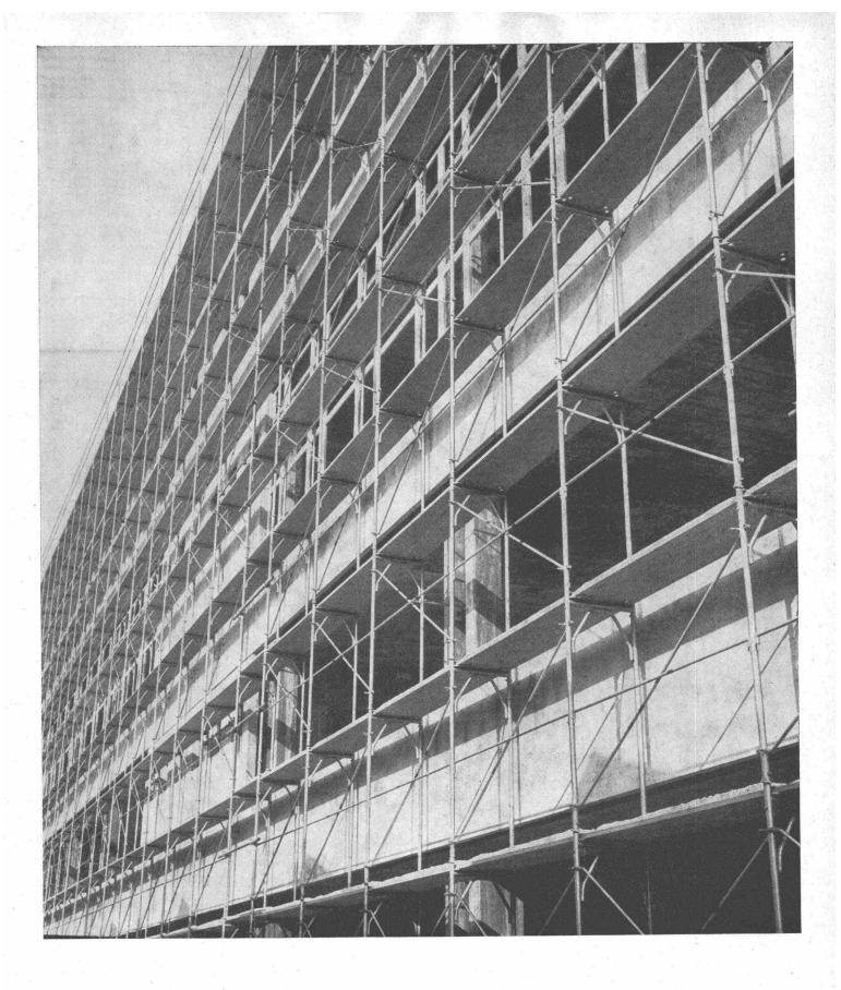
Das Gerüst — allein Mittel zum Zweck — sollte mit möglichst geringem Aufwand montiert und demontiert werden können; es sollen dazu Hilfskräfte eingesetzt werden. Das Gerüstsystem muss also absolut narrensicher und ohne Montageprobleme sein. Um diesem Umstand Rechnung zu tragen, konstruierten wir nach jahrelangen Forschungsarbeiten das leichte und vielseitige Schnellbaugerüst mit eingebautem, fixem Belag. Bitte verlangen Sie unsere ausführliche Dokumentation.
