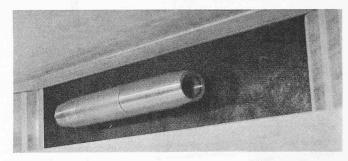
Bild 7. Ansicht der Treibstrahldüse mit Nische
