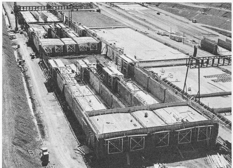
Bild 18. Betonieren der vorfabrizierten Tunnелеlemente. Im Vordergrund Element von 7 × 15,7 m Länge, anschliessend zwei weitere Elemente in den verschiedenen Betonierstadien: ein Abschnitt mit eingeschalteter Decke, drei Abschnitte mit fertig betonierten, ein Abschnitt mit eingeschalteter Seitenwand, zwei Abschnitte mit fertig verlegter Armierung der Bodenplatte
