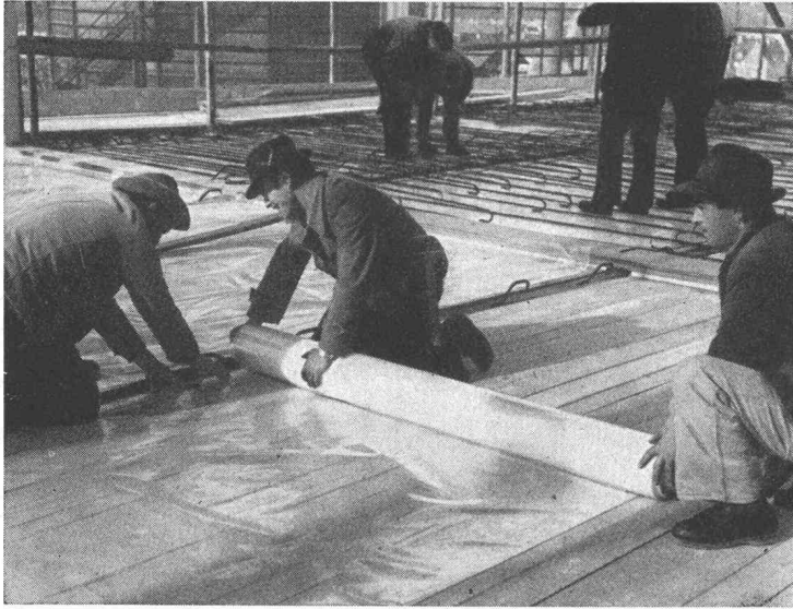
Polyäthylen «Howagaine» im Strassenbau
