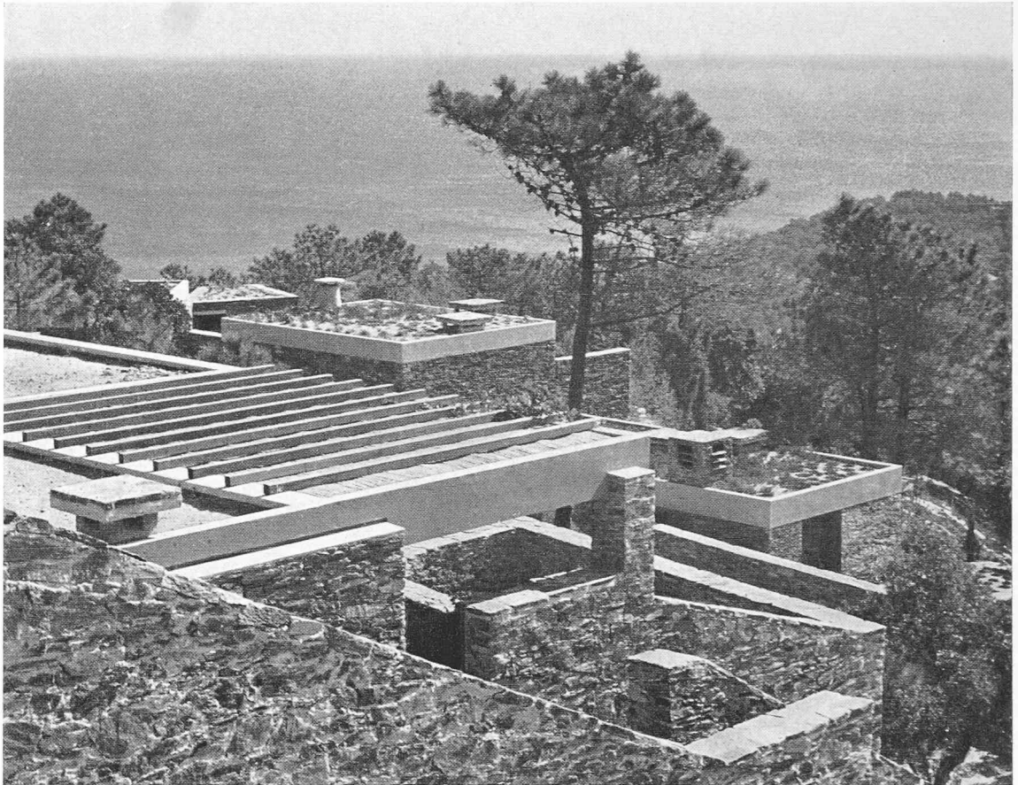
Gaou Bénat, Le village «Les Fourches». Architekten: Le Fèvre et Aubert, Le Lavandou. Blick über die Dächer einer Häusergruppe. Die Wände sind aus Bruchstein der Gegend gemauert, die Flachdächer begrünt
