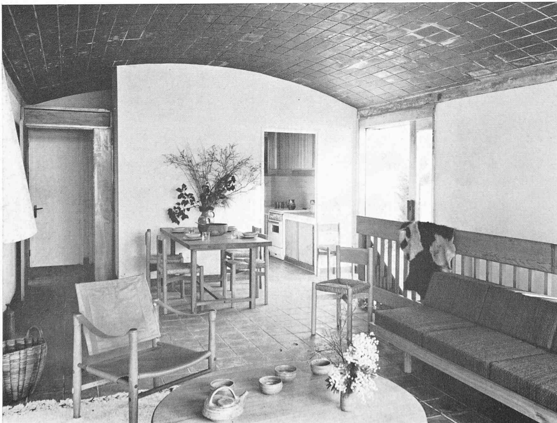
Wohnraum. Blick gegen die Küche. Der Boden und die gewölbte Decke sind mit Tonplatten belegt
