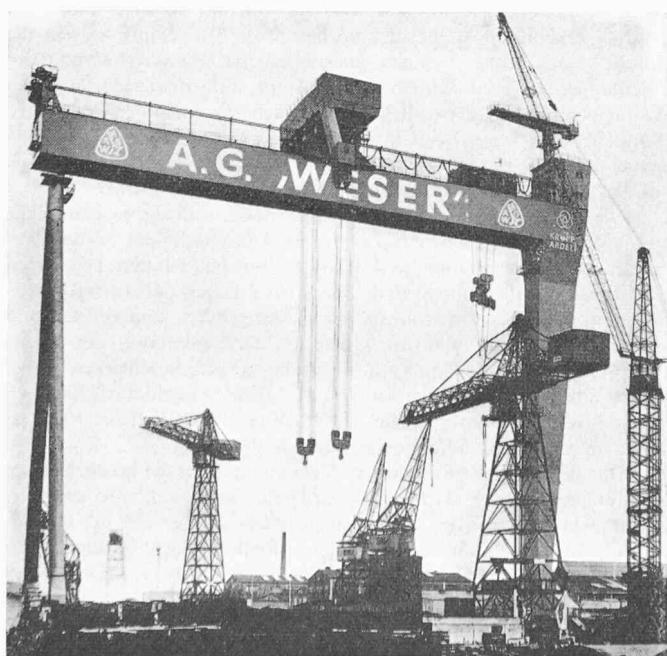
ständigen können. Weiter wurden für alle Bewegungen sehr kleine Geschwindigkeiten gewählt (Katzfahren 0,12 m/min, Kranfahren 0,375 m/min, Verschieben der Oberkatzen-Hubwerke 0,25 m/min; Heben und Senken 0,125 m/min).
