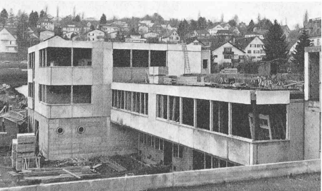
Unten: Blöcke C—D mit fertig versetzten Fassadenplatten (Mai 1964)
