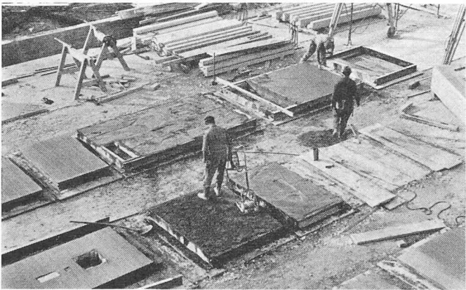
Plattenherstellung auf der Kellerdecke von Block F
