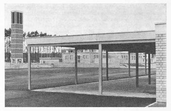
Bild 6. Ebenerdiger Schulbau unter Verwendung von MSH-Profilen
