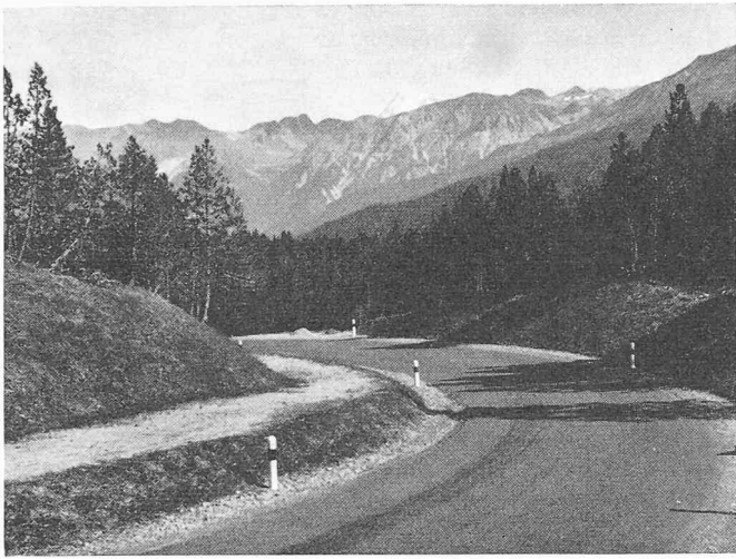
Bild 5. Sterile Kalkschotterböschungen an der Ofenbergstrasse, etwa drei Monate nach Begrünung mittels Saat auf Stroheckschicht. 1700 m Seehöhe
