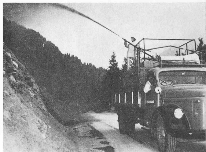
Bild 1. Ansaat einer Strassenböschung mittels «Hydroseed»
