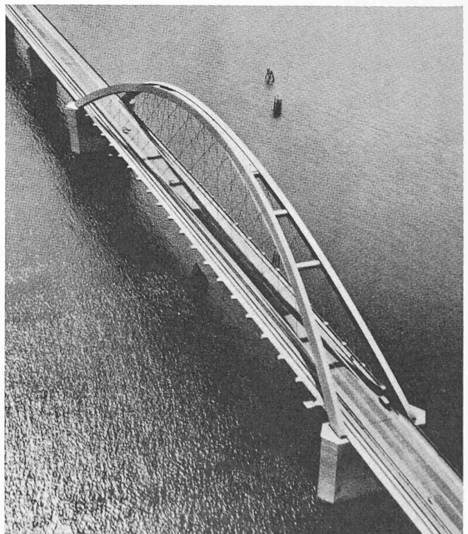
Bild 43. Fehmarnsundbrücke mit bogenüberspannten Balken in der Hauptöffnung
