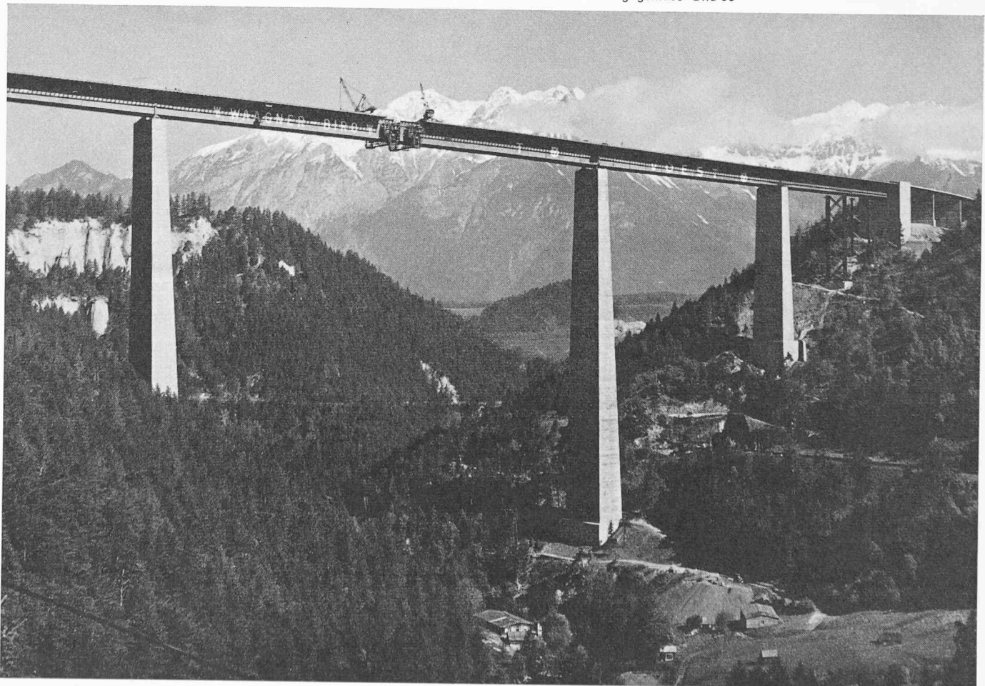
Bild 31. Die Europabrücke zwischen Innsbruck und Brennerpass erhielt eine Fahrbahnsicherung gemäss Bild 30
