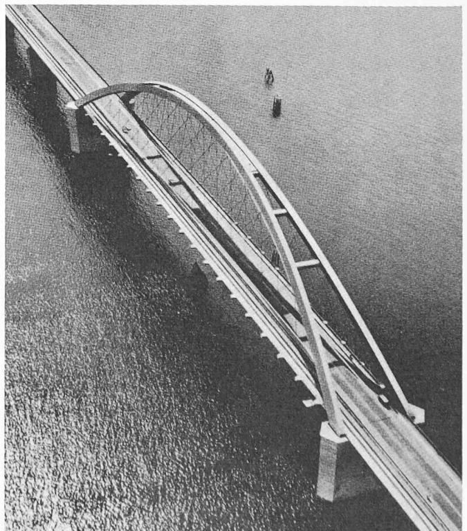
Bild 43. Fehmarnsundbrücke mit bogenüberspannten Balken in der Hauptöffnung
