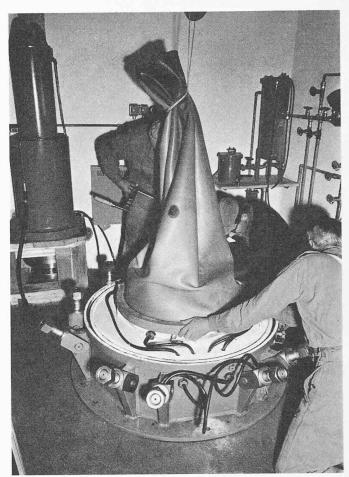
Bild 3. Der Gummimantel wird an der untern Druckplatte befestigt
