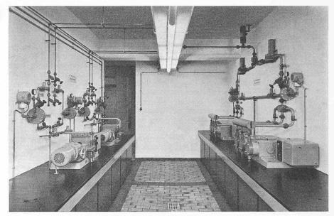
Bild 10. Dosierpumpen für die Entkeimung und Fluoridierung
