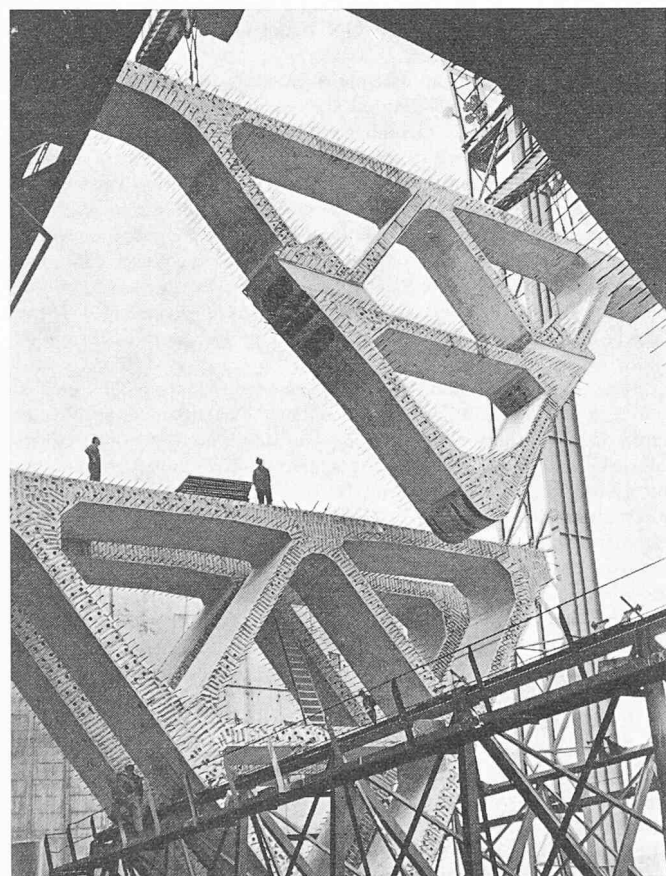
Bild 29. Osterscheldebrücke, Holland. Hohlkastenstücke wurden an stählerne Fachwerkbrücke angehängt und zusammengespannt
