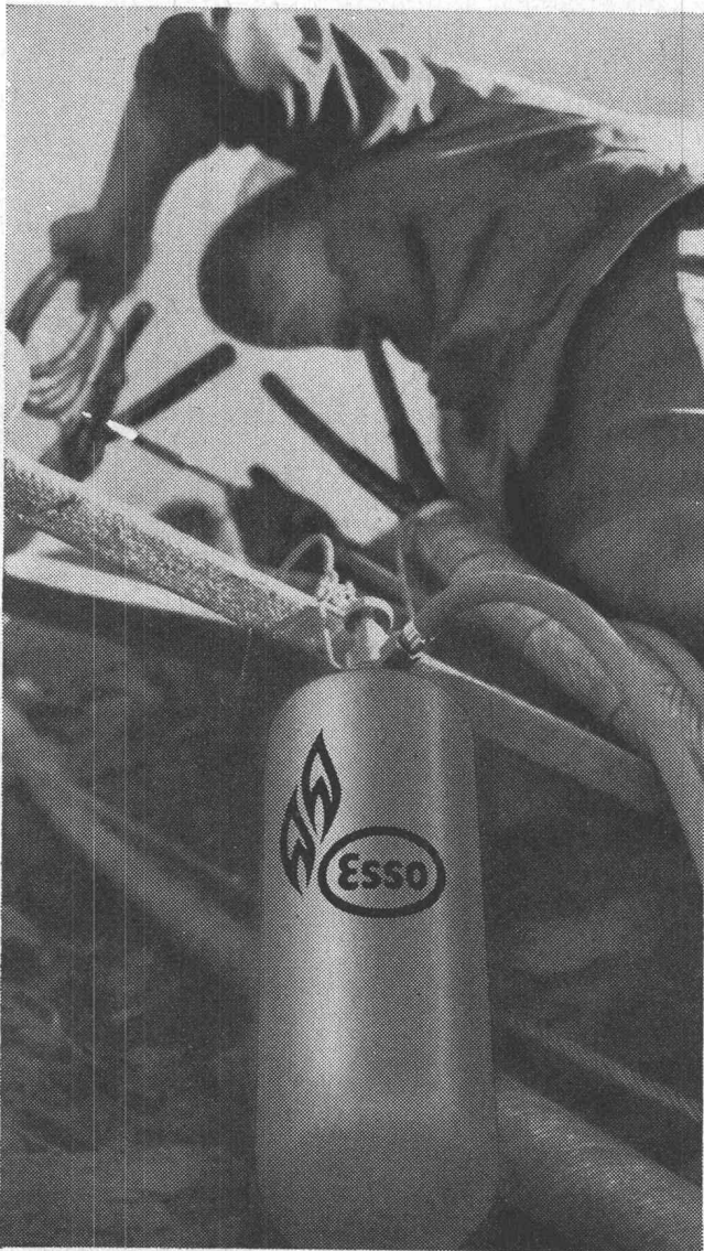
Kabelverlegung an der Schilthornbahn auf 2974 m.ü.M.
