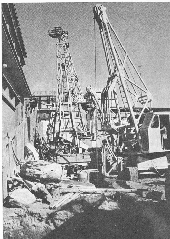
Bild 10. Hotel Continental, Lausanne. Bohr- und Aushubmaschinen bei der Arbeit längs des Fahrweges. Blick nach Osten
