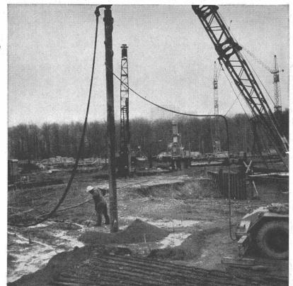
Tiefenverdichtung nach dem RDV für mehrere Klärbecken zur Reduktion der Wasserdurchlässigkeit
