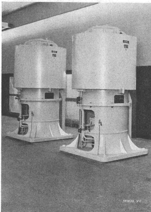
Zwei vertikale 525-kW-Pumpenmotoren, 985 U/min, im neuen Seewasserwerk der Stadt Zürich.
