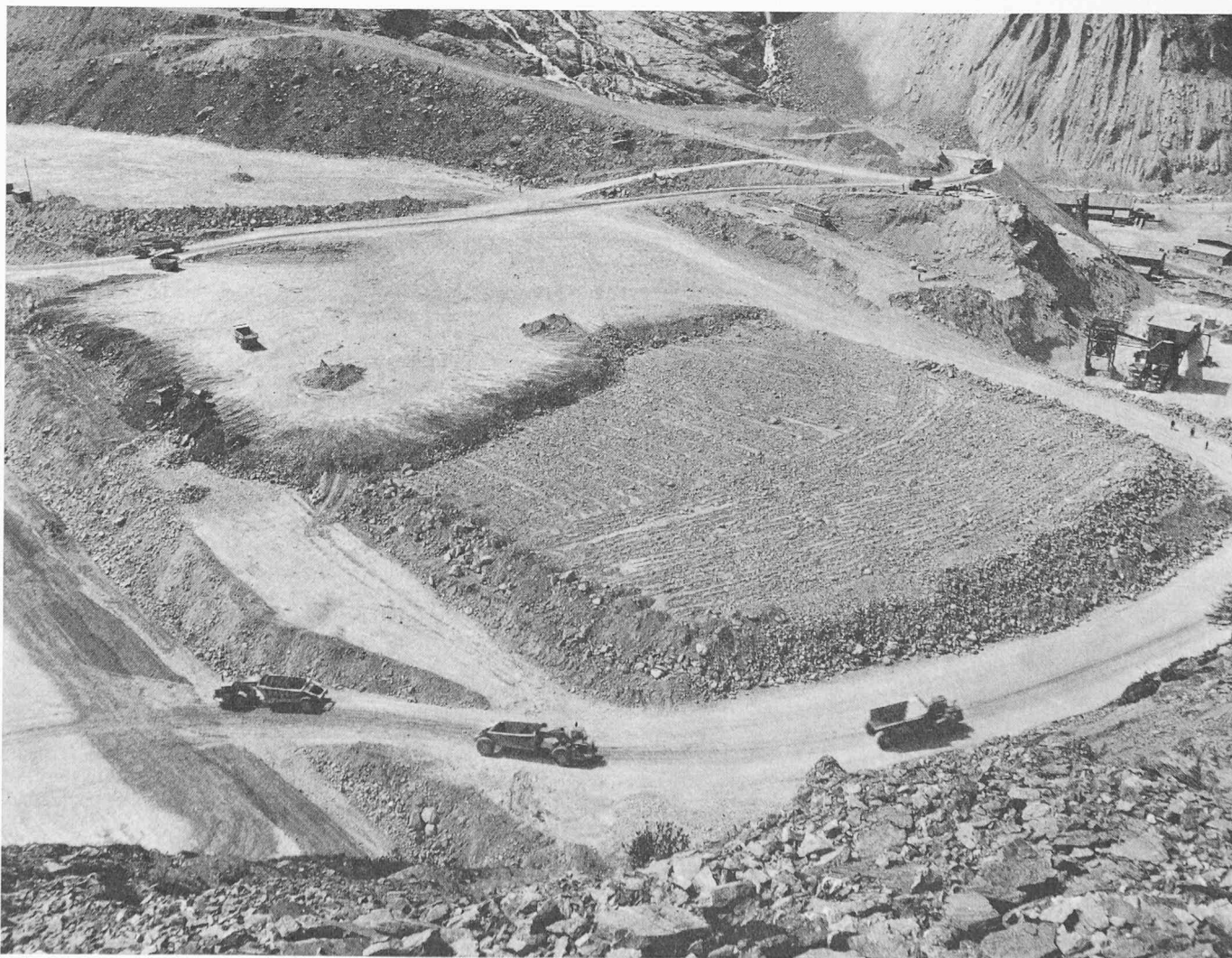
Bild 7. Stützkörperschüttung mit Blöcken bis zu 80 cm Durchmesser. Links Wasserseite, rechts Luftseite
