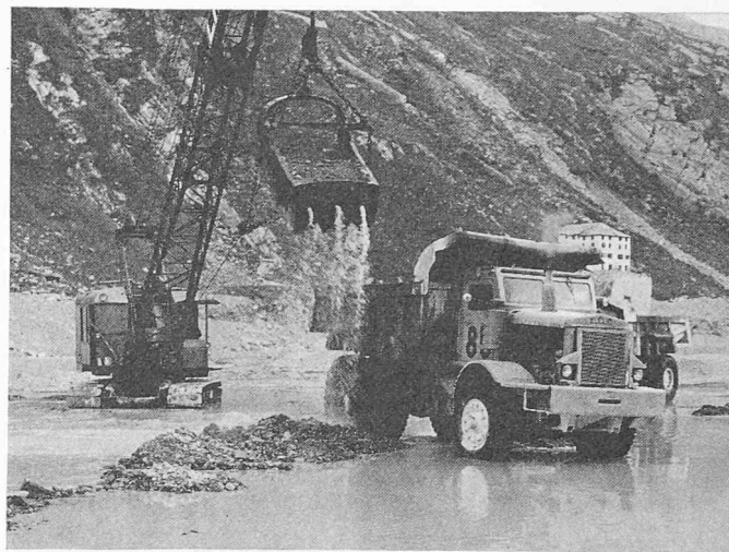
Bild 8. Baggerung des Filter- und Drainagematerials
