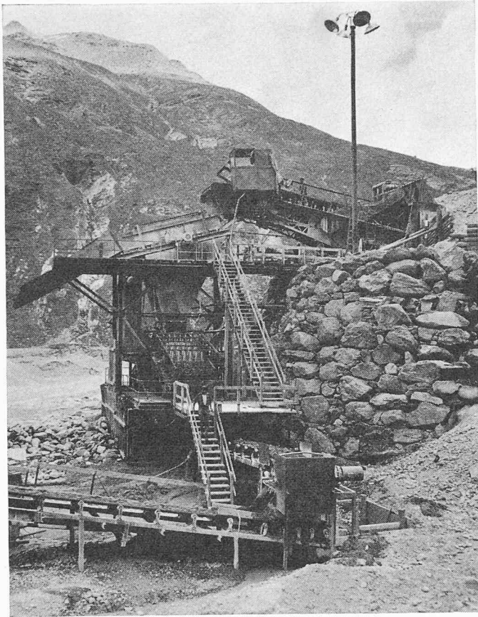
Bild 9. Aufbereitung des Drainagematerials
