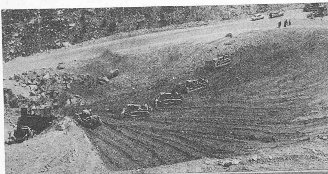
Bild 6. Oben: Bulldozer schieben Moränenmaterial zum Kolmann; unten: der Kolmann-Bandlader in Aktion
