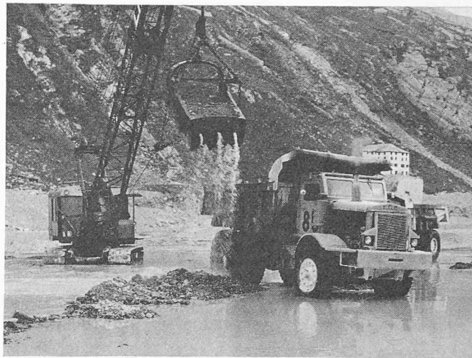
Bild 8. Baggerung des Filter- und Drainagematerials
