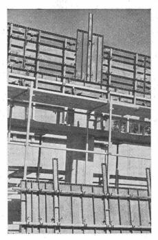
Universal anpassungsfähig: Vollschalung Kletterschalung Gleitschalung usw.
