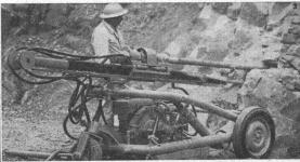
Grosslochbohrwagen mit hydraulischem Antrieb für Loch-hämmer
