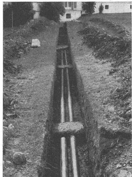
Direkt im Erdreich verlegte Fernheizleitungen  $90/70^{\circ}\text{C}$ .
