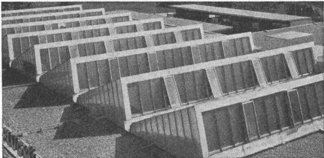
Kittlose Industrieverglasungen seit 1907, eigenes bestbewährtes System mit Leichtmetallsprossen und Bleibanden. Glasdachzubehör: Ventilationshüte, Lüftungsflügel, Sheddächer.
