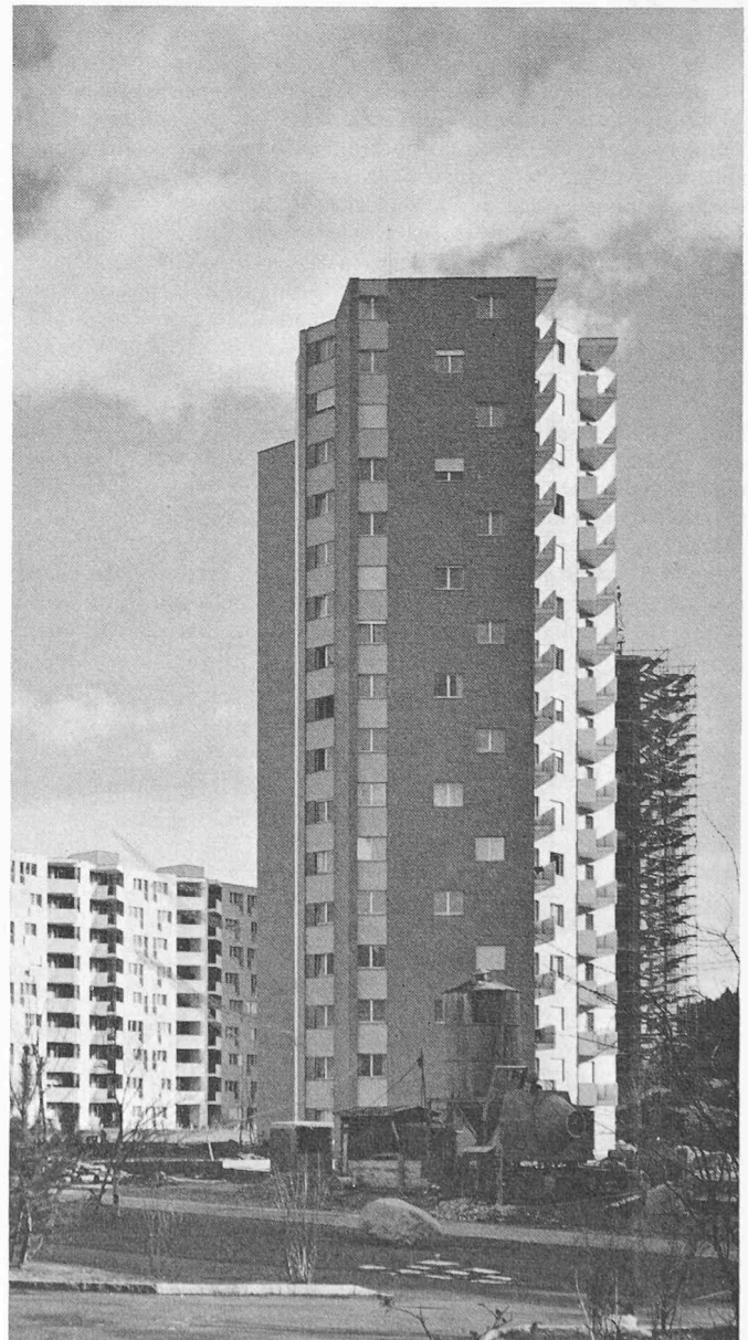
Bild 1. Hochhaus erbaut 1959/61 in Biel, 16 Geschosse aus Backsteinmauerwerk. Photo P. Moosbrugger
