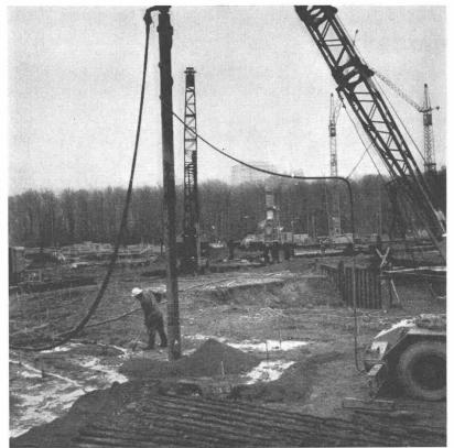
Tiefenverdichtung nach dem RDW für mehrere Klärbecken zur Reduktion der Wasserdurchlässigkeit
