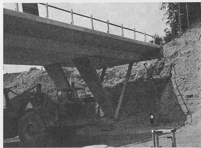
Bild 2. Schrägstiele vor dem Einschütten. Dank dem statischen System von V-förmigen Stützen sind für die Brücken nur zwei Fundamente nötig
