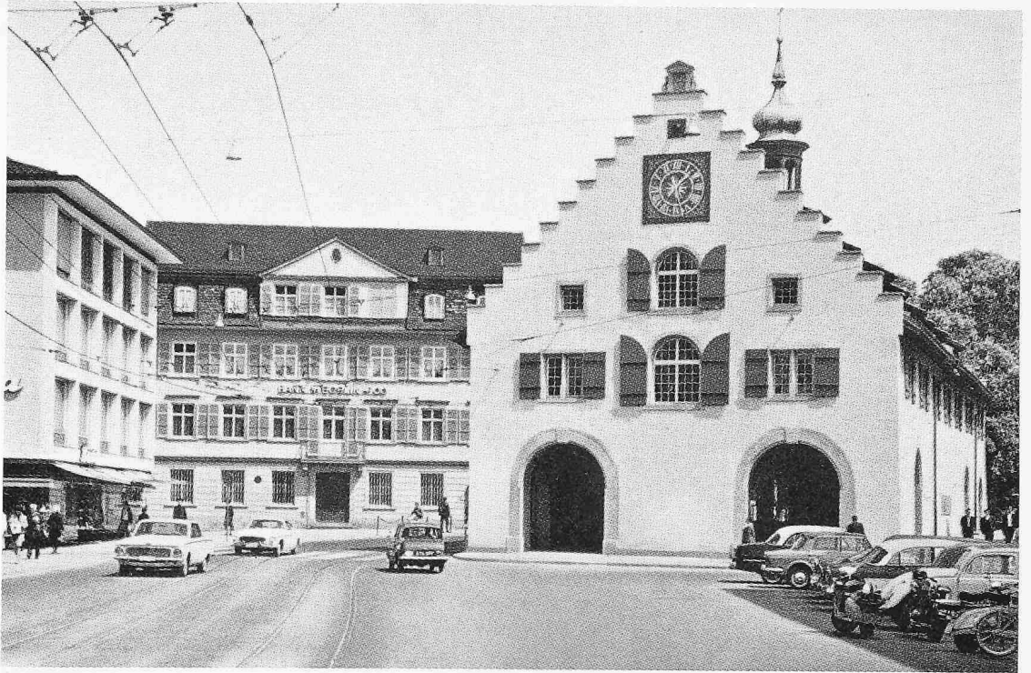
Die Westfassade des renovierten Waaghauses aus Richtung Marktplatz gesehen
