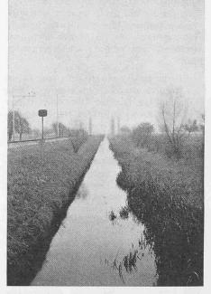
Bild 7 (oben); Starke Verkrautung und zunehmende Verlandung hemmen den Wasserabfluss im Vilterser-Wangser-Kanal.
