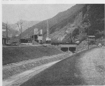
Bild 14. Korrektion des Trübbaches, der über den neuen Saarkanal hinübergeführt wird.
