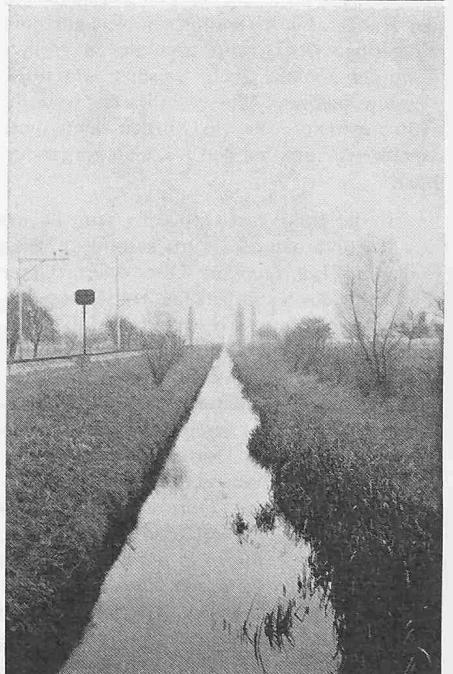
Bild 7 (oben): Starke Verkrautung und zunehmende Verlandung hemmen den Wasserabfluss im Vilterser-Wangser-Kanal.
