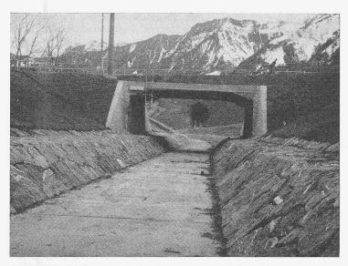
Bild 17. Detail des fertigen Kanales mit der seitlichen Pflästerung und der betonierten Sohle sowie der neuen Strassenbrücke Trübbach—Mäls FL.
