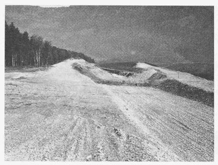
Bild 12. Der Saarableitungskanal im Bau, untere Baustrecke. Man erkennt die Schüttung sowie im Querschnitt dunkler die Lehmabdichtung. Der Kanal liegt hier über dem Terrain,
