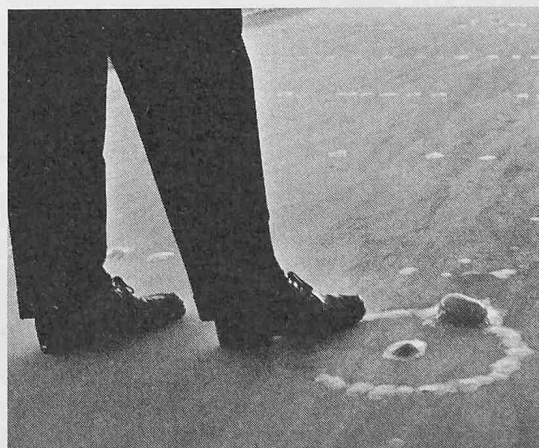
Bild 6. Die Wirkung eines Tiefstrahlers nach einer feuchten Nacht im November 1963. Die Lampen-Unterseite befand sich etwa 2,3 m über der Piste. Im Hintergrund Tropfenspuren der Balken, Balkenunterkante etwa 2,5 m über der Piste
