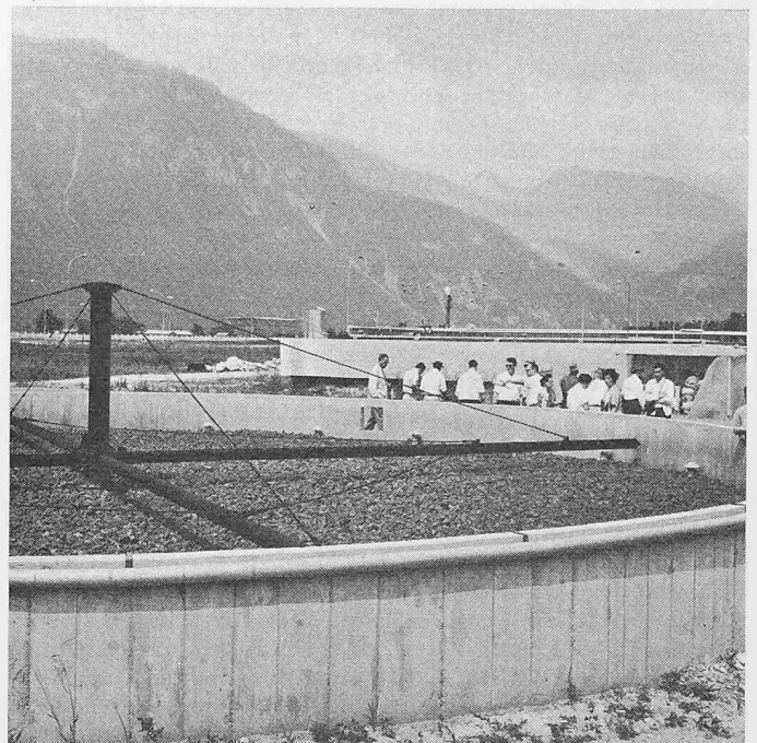
Bild 8. Biologische Wassereinigung: Tropfkörper
