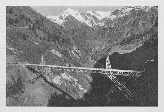
Vom Bau der Dienstbrücke Staumauer Luzzone (180 m in Holz!). Das kühn auskragende Werk versinnbildlicht in seinem Aufbau engstes Zusammenwirken von konstruierendem Ingenieur und ausführenden Zimmerleuten von altem Schrot und Korn. Für solche Aufgaben bedarf es Gerüstbauer von Format, Kämpfer, Praktiker!
