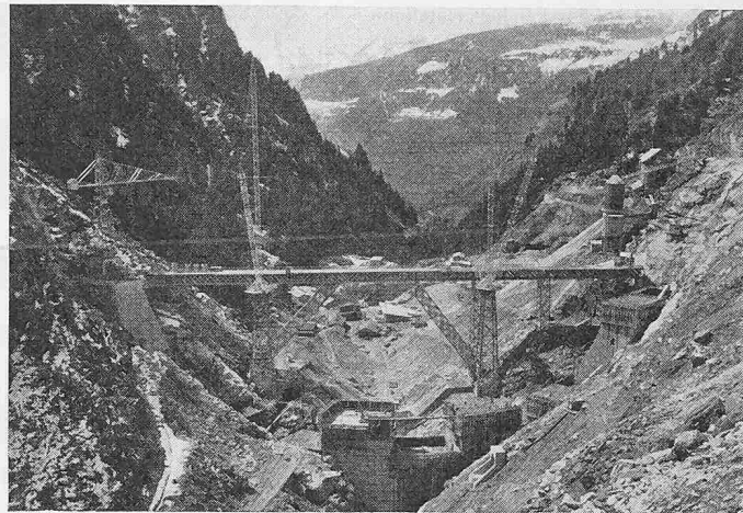
Staumauer Malvaglia, 30 m hohe Derrick-Unterbauten und Dienstbrücke. Mit Phantasie und Wagemut ist Ing. Hans Kaegi seinem leider allzu früh verstorbenen Freund, Obering. A. Lüchinger, im rauen Bergklima an die Hand gegangen
