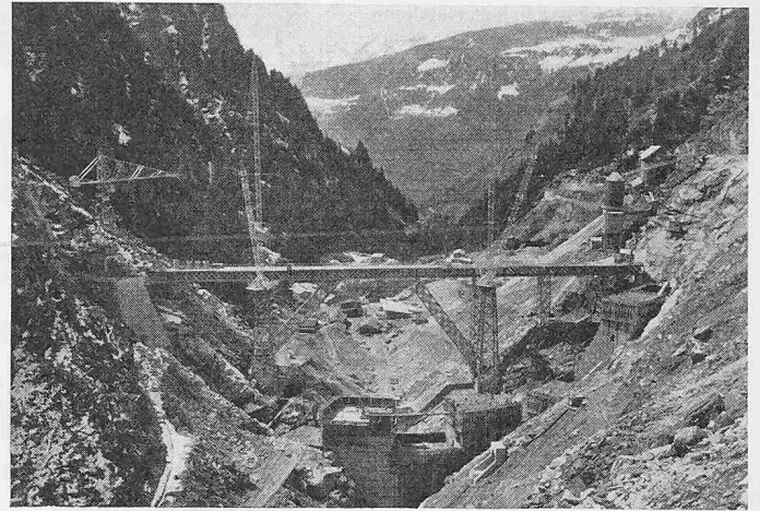
Staumauer Malvaglia, 30 m hohe Derrick-Unterbauten und Dienstbrücke. Mit Phantasie und Wagemut ist Ing. Hans Kaegi seinem leider allzu früh verstorbenen Freund, Obering. A. Lüchinger, im rauhen Bergklima an die Hand gegangen
