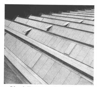
Shed-Fenster in kittloser Konstruktion System WEMA
