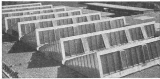
Kittlose Industrieverglasungen seit 1907, eigenes bestbewährtes System mit Leichtmetallsprossen und Bleibanden. Glasdachzubehör: Ventilationshüte, Lüftungsflügel, Shedrinnen.
