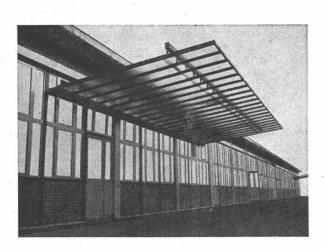
Glasvordächer in kittloser Konstruktion System WEMA
