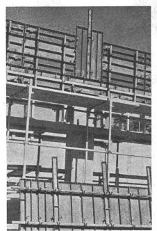
Universal anpassungsfähig: Vollschalung Kletterschalung Gleitschalung usw.
