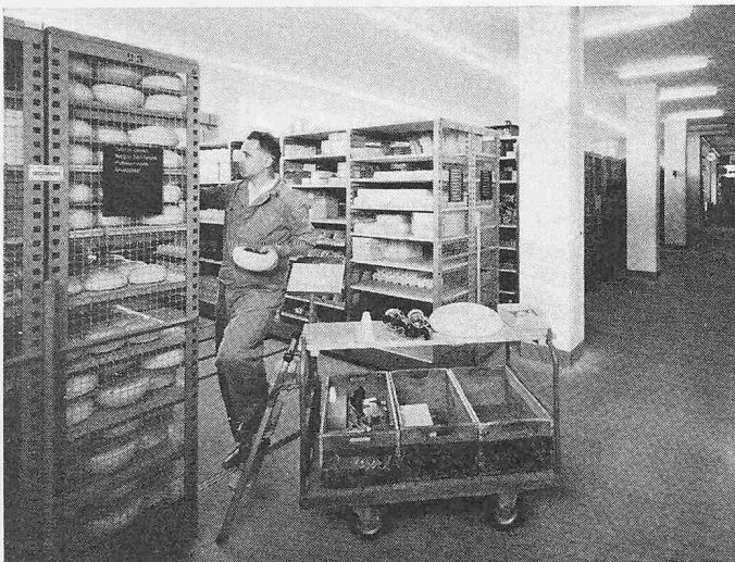
Lager für Hausinstallationsmaterial (Bau II). Der Wagen, der mit einer kleinen Treppe ausgerüstet ist, dient zur Aufnahme der Speditionskisten. Die Bauart der Stahlprofilgestelle ist deutlich ersichtlich
