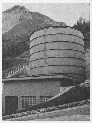
Bild 4. Wasserschloss oberhalb der Zentrale Obermatt
