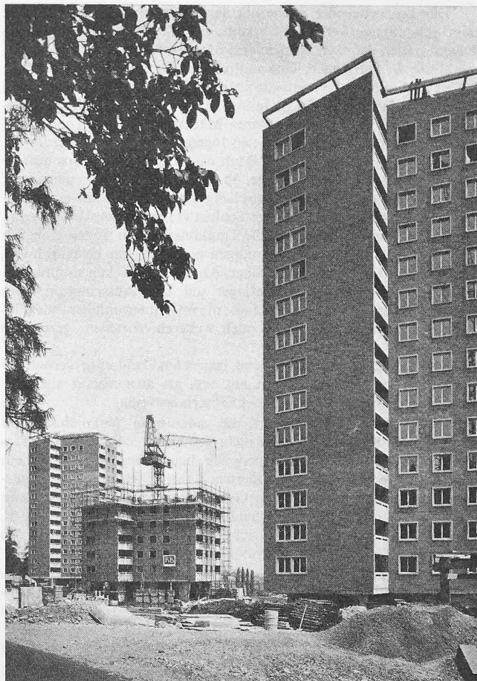
Wohnhochhäuser Holligenstrasse in Bern. 14 Stockwerke in tragendem Backstein-Sichtmauerwerk
