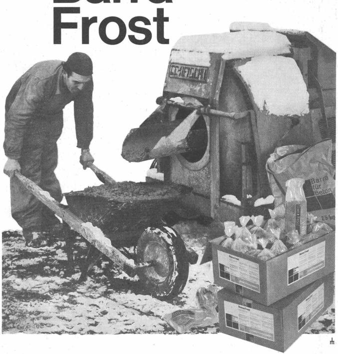
Barra Frost, das sicher wirkende Frostschutzmittel von Meynadier ermöglicht das Betonieren bei Temperaturen bis zu -7° C. Barra Frost plastifiziert, erniedrigt den Gefrierpunkt und beschleunigt die Festigkeitsentwicklung bei tiefen Temperaturen. Barra Frost ist chlorfrei und greift deshalb Eisen nicht an.
