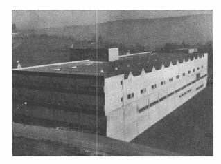
Sattelglasdächer in kittloser Konstruktion System WEMA
