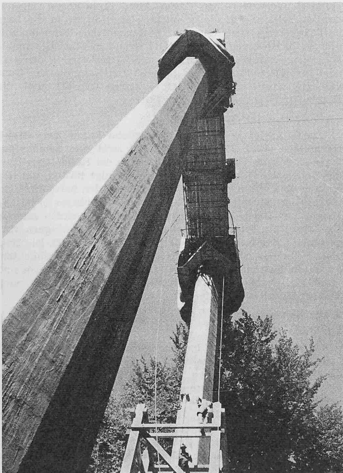
Bild 18. Hochziehen eines Pfeilerpaares mit hydraulisch gesteuerten Stahlgleitschalungen
