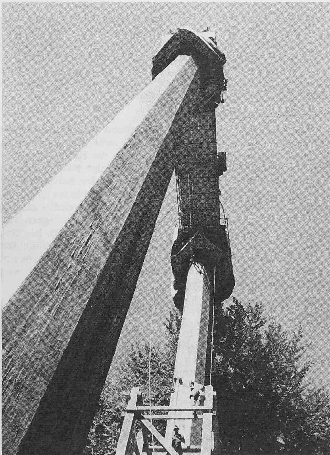
Bild 18. Hochziehen eines Pfeilerpaares mit hydraulisch gesteuerten Stahlgleitschalungen
