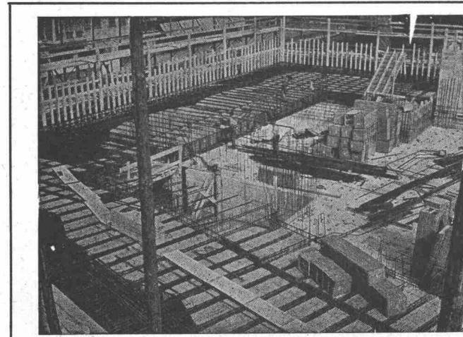
**ROBUR Schilfrohrzellen für Betondecken**
