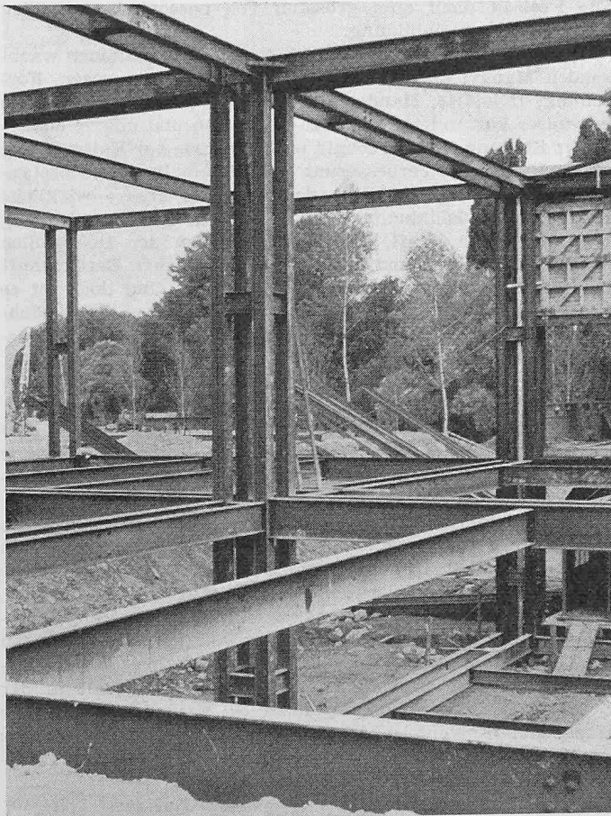
Bild 2. Stahlskelett der Normalbauten
