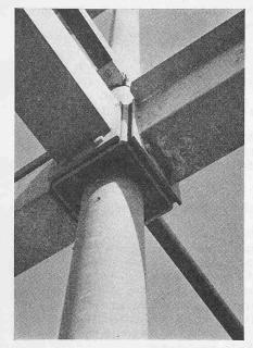
Bild 5. Knotenpunkt mit Anschluss der Rinnen an die Stütze
