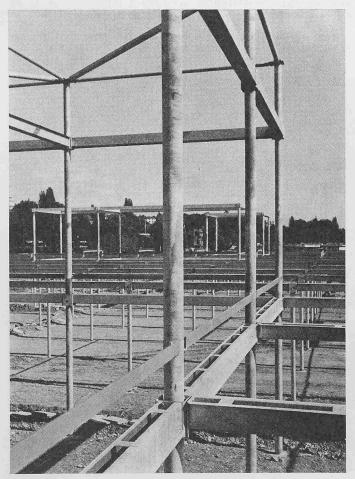
und der Auflagerung der Traufabschlussprofile dienen. Nachträglich gewünschte Zusatzkonstruktionen wurden mittels Rohrschellen an die Stützen angeklemmt.
