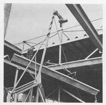
Bild 8. Montage der Eternit-Dach-Formstücke
