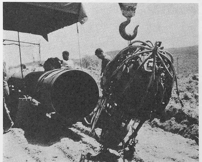
Spannvorrichtung zum Ausrichten zweier aneinanderzuschweisenden Rohre
