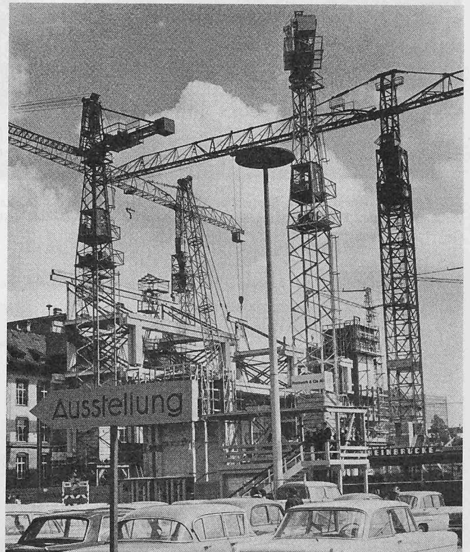
Bild 40 (rechts). Elf Krane wurden für das schnelle Errichten des Bauwerkes eingesetzt
