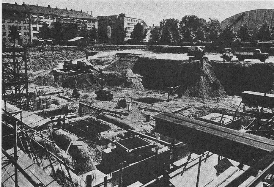
Bild 39. Die Baugrube am ehemaligen Standort der Holzhalle 9 im Juni 1963. Ende August war der 120 000 m 3 umfassende Aus-hub beendet
