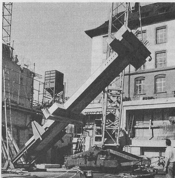
Bild 37. Aufrichten einer Kellerstütze durch den 60-t-Mobilkran
