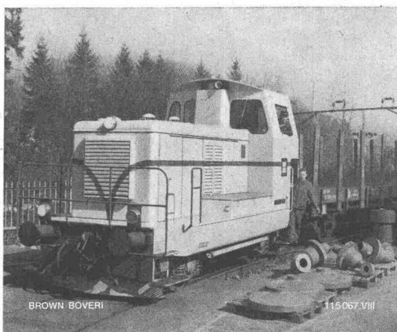
Dieselelektrische Industrielokomotive, 330 PS, 55 km/h, 11,7 t Anfahrzugkraft.
