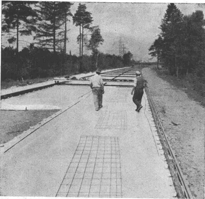
Polyäthylen «Howagaine» im Strassenbau
