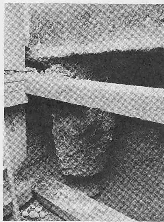
Bild 11. Oberer Teil des Pfahles fehlt überhaupt
