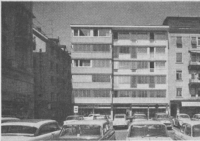
Bild 2. Anstelle der beiden Zürcher Altbauten «Bollerei» und «Seehof» am Limmatquai (Schiffplände) wurde ein Geschäftshaus erstellt (Architekten: E. u. R. Lanners und R. Wahlen, Zürich). Der Neubau übernimmt in seiner Fassadengliederung den Masstab der angrenzenden Häuser, indem zum Beispiel ein Fensterband durch einzelne türhohe Elemente unterbrochen wird. Etwas hart wirkt der über beide sich voneinander abhebenden Hausteile hinweggezogene Vorsprung des auf dem Bilde nicht erkennbaren Schrägdaches. Foto: Peter Grünert, Zürich 1
